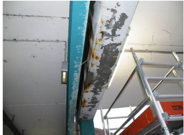
Bild 3: Korrosion eines Stahlträgers und eines Betonunterzugs mit Flächen, die für eine Instandsetzung nur schwer zugänglich sind.
