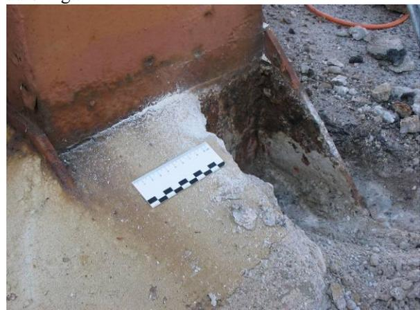
Bild 2: Infolge Korrosion im Erdübergangsbereich stark geschädigte Stütze.
